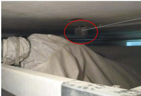
Beim Einblasen legt sich das Gewebe des Sacksilos um die Lampe. Wenn diese eingeschaltet wird und länger brennt, kann es zu einer Temperaturerhöhung kommen, die zu einem Brand führen kann.
